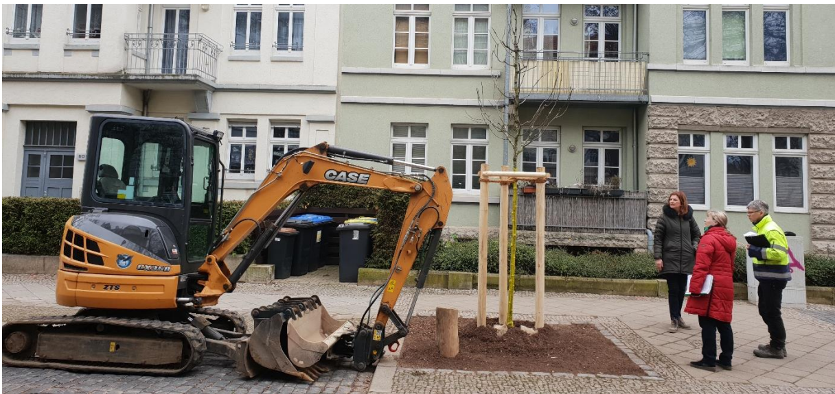
Abbildung 2: Bauberatung und Abnahme eines frisch gepflanzten Dreizahn-Ahorns ( Acer buergerianum ) in der Geschwister-Scholl-Straße in der Erfurter Oststadt. Zu sehen ist auch der Holzpoller zum Schutz vor Verdichtung. Foto: G. Spohr, LHE.
