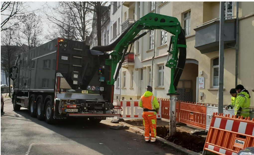
Abbildung 1: Mit dem Saugbagger werden in der Reißhausstraße Leitungen und Wurzeln vorsichtig freigelegt. Foto: G. Spohr, LHE.
